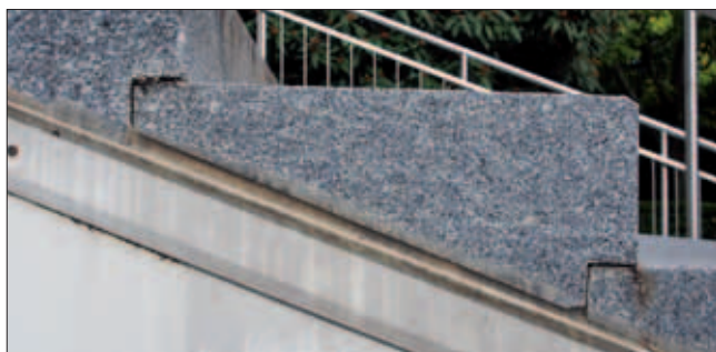
Alle Außenstiegen werden regelmäßig auf Verschiebungen und Frostschäden überprüft
