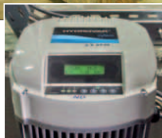
Steuerung für eine Drucksteigerungspumpe: Programmierbar und verbunden mit der Zentralen Leitstelle
