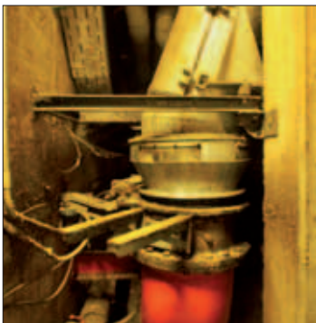
Ventil am unteren Ende des Müllschluckers
