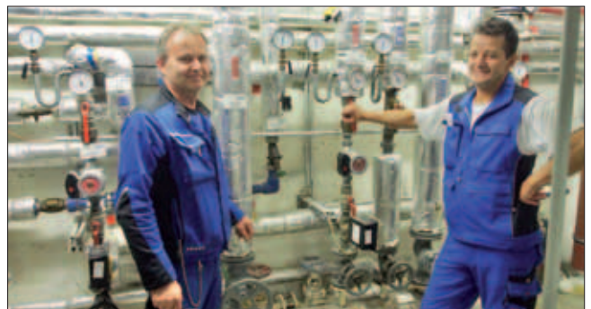
Lüftungszentrale A6/7: Mariusz Baranowski und Robert Kalchbauer - langjährige Lüftungstechniker im Wohnpark
